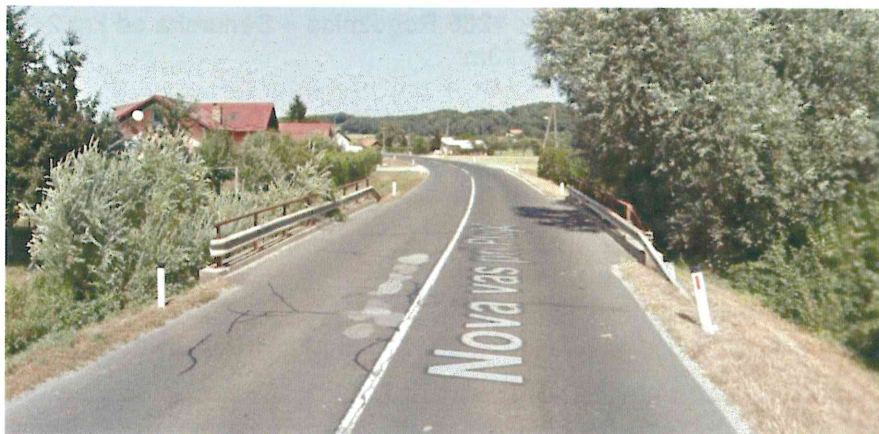
Slika 2: Obstoječ premostitveni objekt – most čez neimenovani vodotok (vir: Google Maps)
