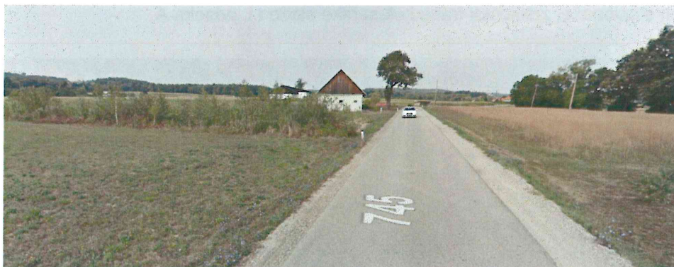
Slika 9: Obstoječa cesta R3 745 odsek 4116 (vir: Google Maps)
