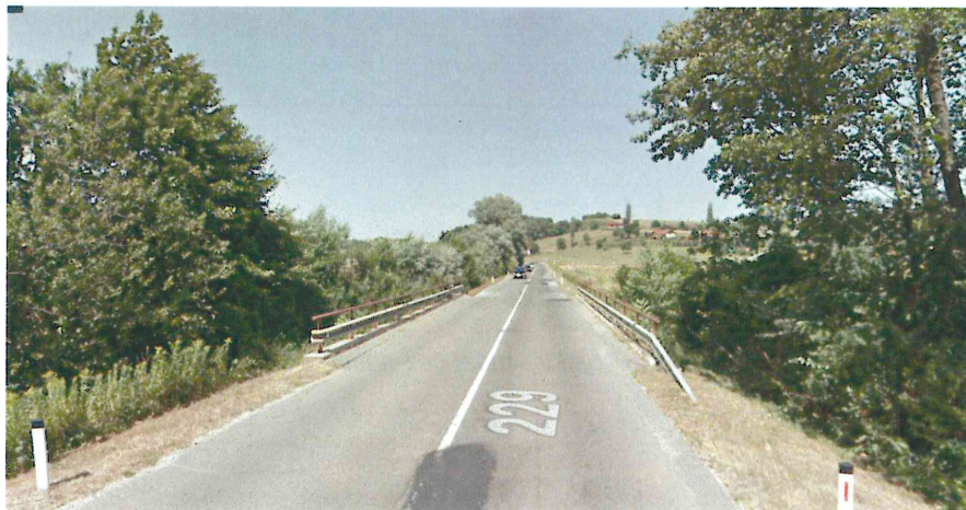
Slika 6: Obstojč premostitveni objekt – most čez vodotok Rogoznica (vir: Google Maps)
