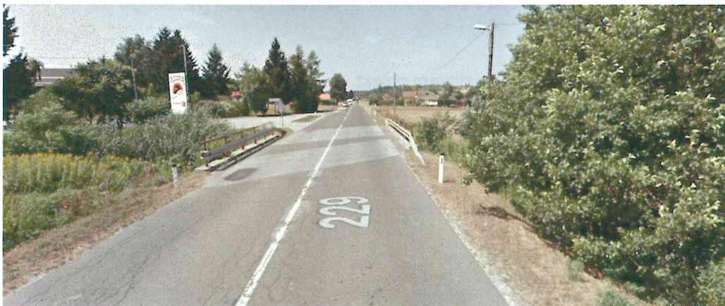
Slika 4: Obstojč premostitveni objekt – most čez neimenovani vodotok (vir: Google Maps)
